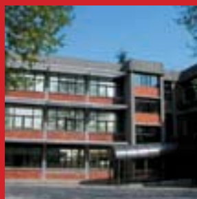
Pellicole isolanti sulle vetrate della scuola rossa
