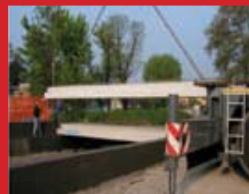
Lavori in corso al ponte di Via Oberdan: la posa delle travi
