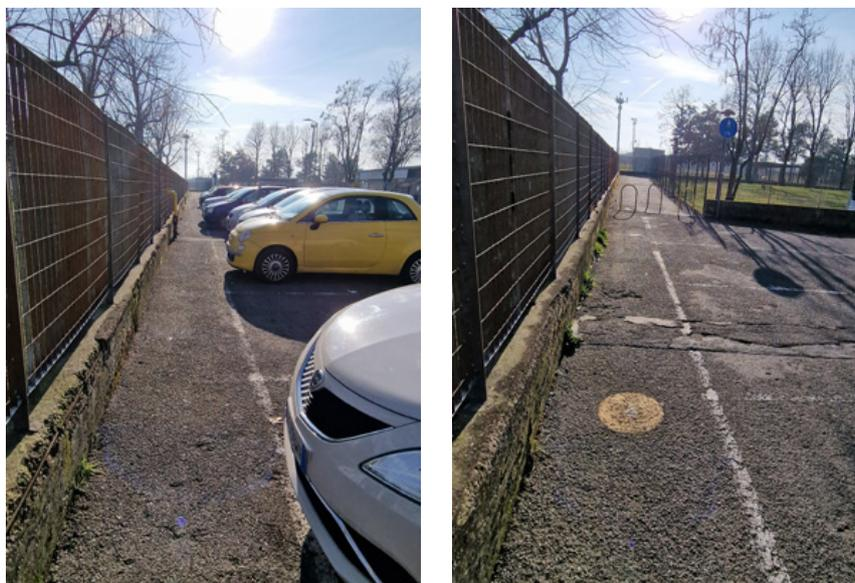
Descrizione prestazionale possibile intervento: Inserimento di fermaruota in corrispondenza di stallo di sosta autovettura al fine di evitare la riduzione della larghezza del percorso pedonale esistente.
