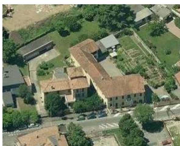
Edificio in via Garibaldi
