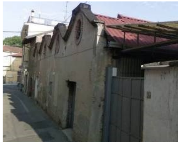
Edificio produttivo in via Piave
