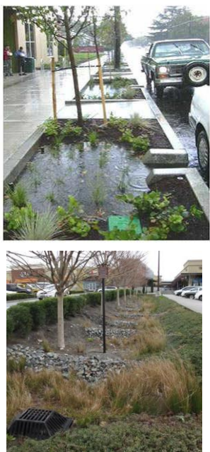
Figura 93 – Interventi d'invarianza idraulica per la viabilità: aiuole e cunette
