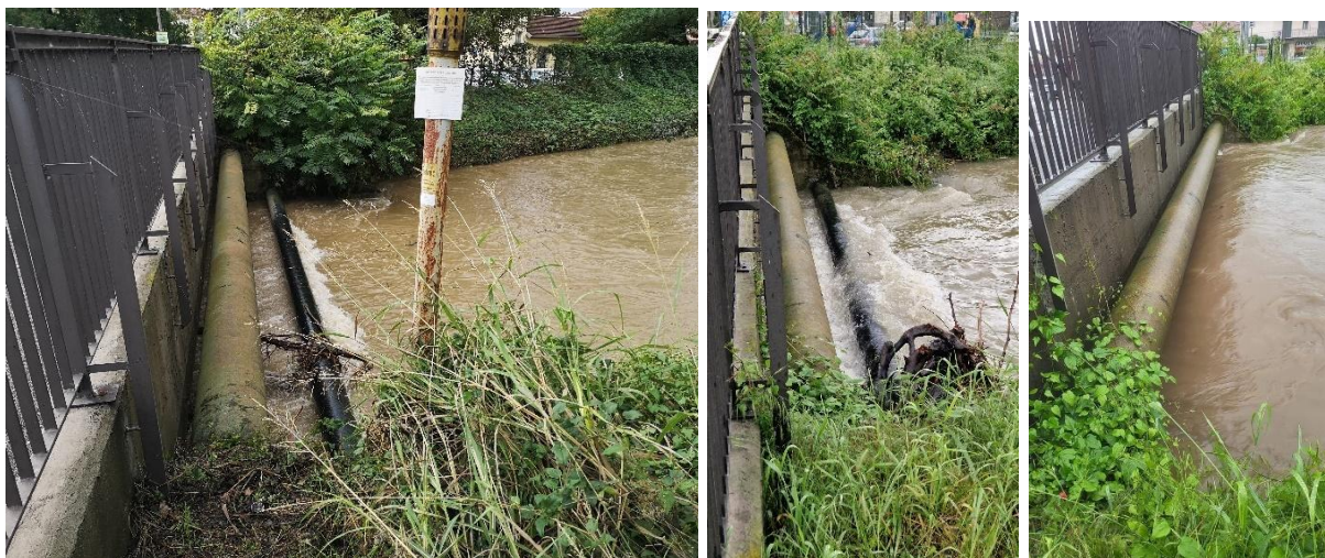
Figura 7 – Ponte di Largo Marinai d'Italia (a monte) durante due distinti eventi: a sinistra il 05/10/2021, al centro e a destra il 16/05/2024: è evidente l'insufficienza idraulica dell'attraversamento stradale, peggiorata dalla presenza di tubazioni di sottoservizi poste a quote del tutto inadeguate (a destra la prima tubazione era sommersa)
