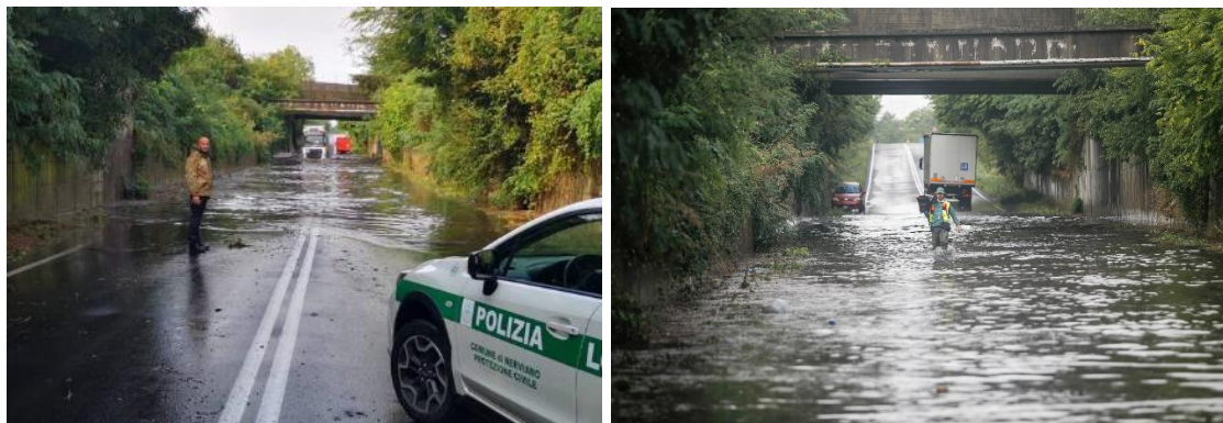
Figura 91 – Immagini di alcuni allagamenti subiti dal sottopasso stradale della SP (punto 4 riferimento della tavola SGRI.06)
