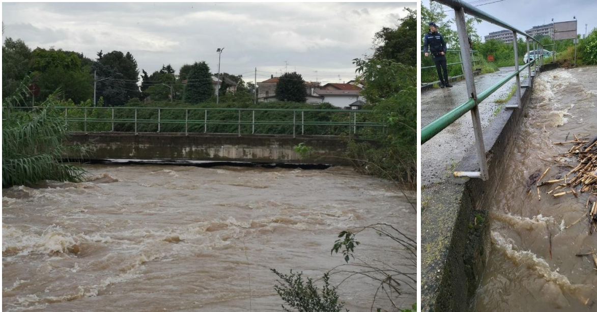
Figura 6 - Ponte della Cassinetta: a sinistra durante la coda di un evento di morbida del 05/10/2021(vista da monte); a destra l'evento di piena del 16/05/2024: risulta evidente l'insufficienza idraulica del ponte e il pericoloso funzionamento in pressione
